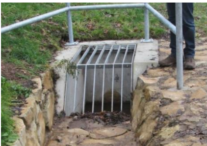
Mehrdimensionale Einlaufrechen und -gitter, vorgesehen für verschiedene Durchlässe
