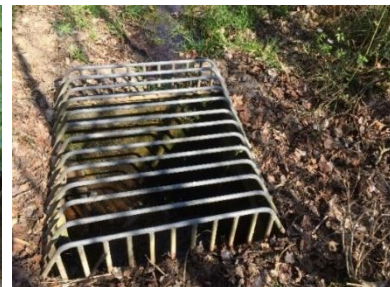
Mehrdimensionale Einlaufrechen und -gitter, vorgesehen für verschiedene Durchlässe
