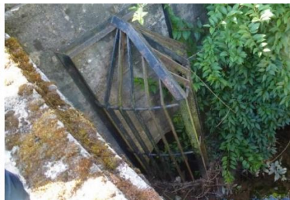
Mehrdimensionale Einlaufrechen und -gitter, vorgesehen für verschiedene Durchlässe
