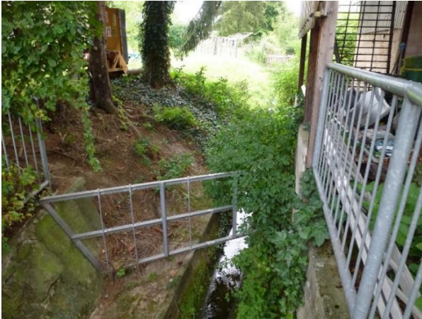
Verlegung des Treibgutrechens nahe Weidenbornstr. bachaufwärts, ggf. mit Rampe für besseren Zugang
