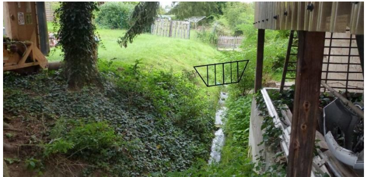
Verlegung des Treibgutrechens nahe Weidenbornstr. bachaufwärts, ggf. mit Rampe für besseren Zugang
