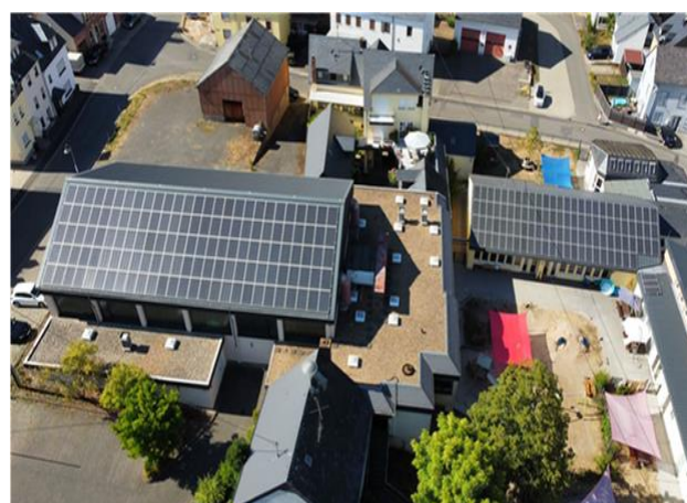
Abbildung 45: PV-Dachflächenanlage (Quelle: L. Klassen)
